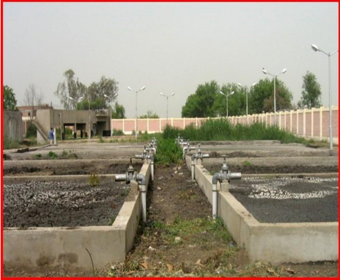
صورة رقم 4 توضح أحواض التجفيف الطبيعي
