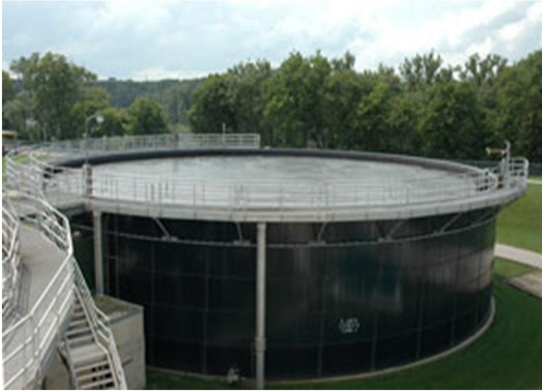
صورة رقم 1 توضح حوض التكتيف الدائرى الشكل
