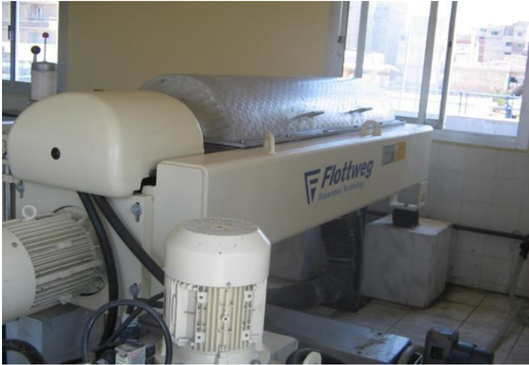
صورة رقم 0 - أ توضح مُعدة التجفيف باستخدام الطرد المركزى
